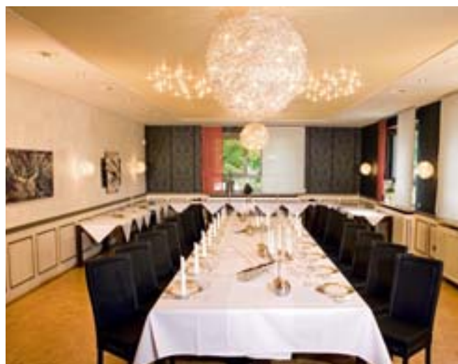
Drei Spanndecken für den Bankettraum: umlaufendes Spanndecken-Fries, großes Spanndeckenfeld mit Designleuchten und revisionierbarem Kasten für Klimaanlage.
